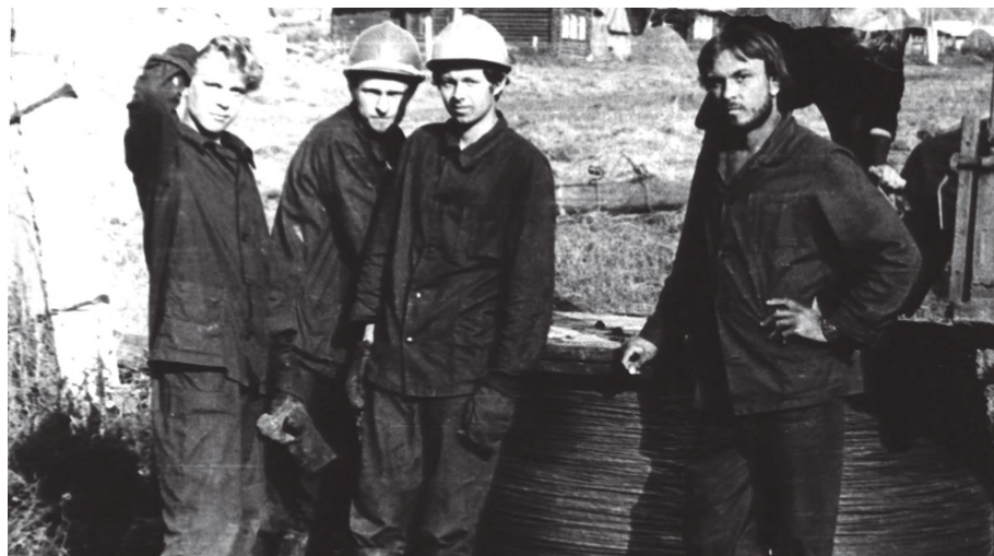
Командир специализированного студенческого строительного отряда «Электроника» Александр Степанов (крайний справа) на прокладке линий электропередач в республике Мордовия, 1983 год
